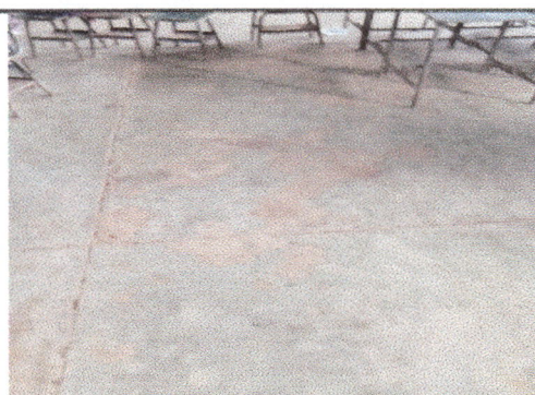
Foto 5: Piso de torta de concreto de corredor con grietas
