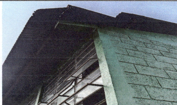
Foto1: Vista panorámica estado actual de cubierta de lamina de escuela.
